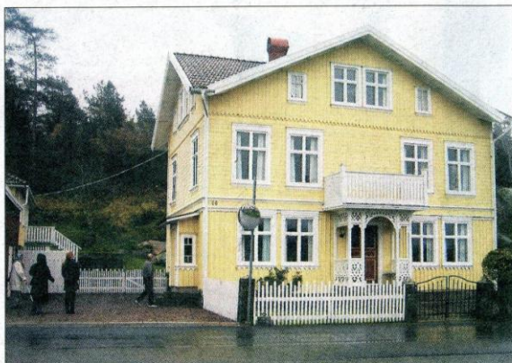
Den ståtliga gula 1900-talsvillan i Kämpersvik har under åren välbevarats med små förändringar. Fastighetsägarna Eva och Nils Mattsson tilldelas därför miljö- och byggnadsnämndens byggnadsvårdspris för sitt arbete.
